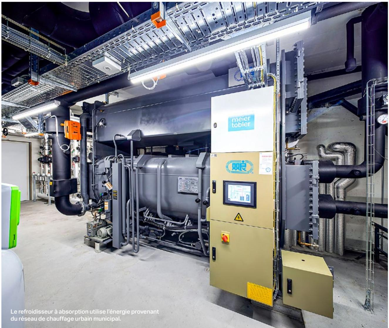
Le refroidisseur à absorption utilise l'énergie provenant du réseau de chauffage urbain municipal.
